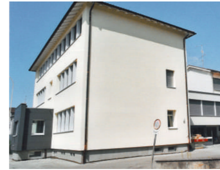
Renovierter Altbau 2000 mit der markanten «Black Box», dem neuen Sekretariatsbüro.
